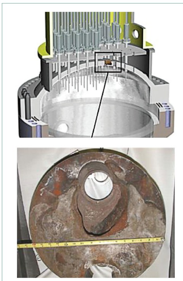
Ilustración 11: Arriba se aprecia la localización del punto degradado de la tapa de la vasija. Abajo se aprecia el agujero causado por la corrosión por ácido bórico en la tapa. Fuente: (58)
